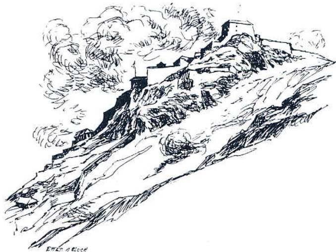
Frederiksstens Fæstning. Som man ser er det ikke særlig nemt at angribe den uden et større gravearbejde op ad bjergskråningerne, samtidig med forsvarerne har fin indsigt og frit skudfelt ned mod angriberen.
